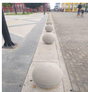
Figura 06 Balizadores (esferas em concreto) Foto dos autores
