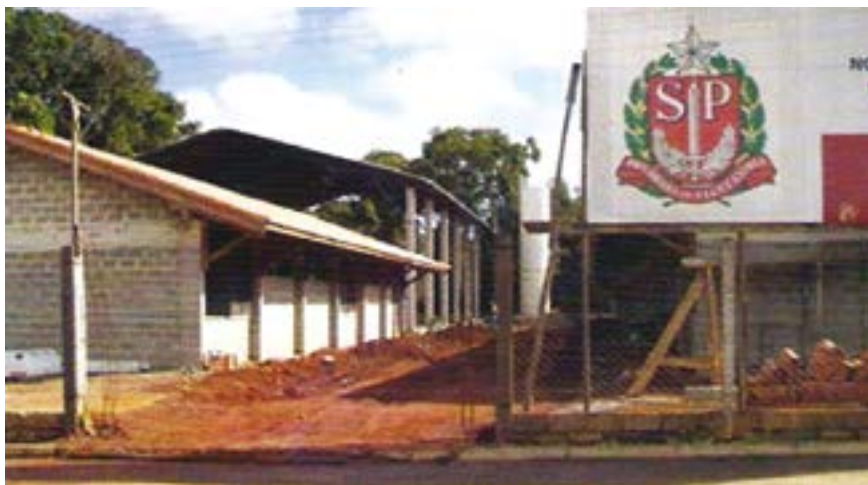
Figura 156 – Construção da E.E. Massanori Karazawa.
