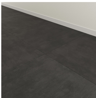
Figura 55. Pisos de Borracha - Exemplo de instalação de piso de borracha em corredor residencial.
